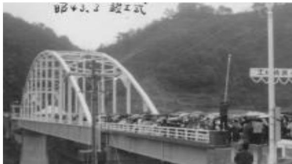
昭和43年 新月ヶ瀬橋竣工式
