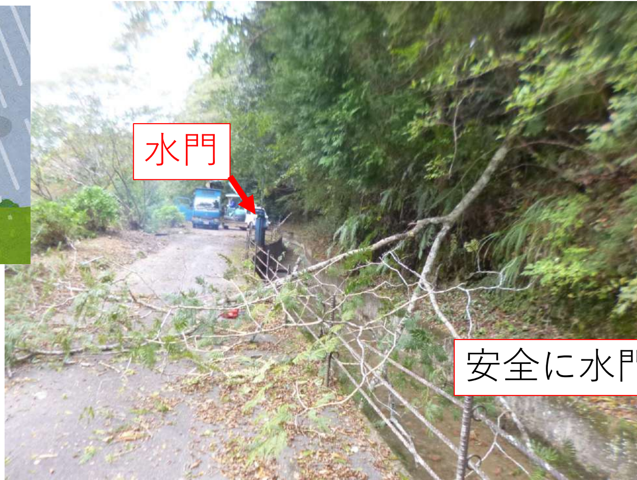
台風時の鳴谷ゲート付近の倒木
