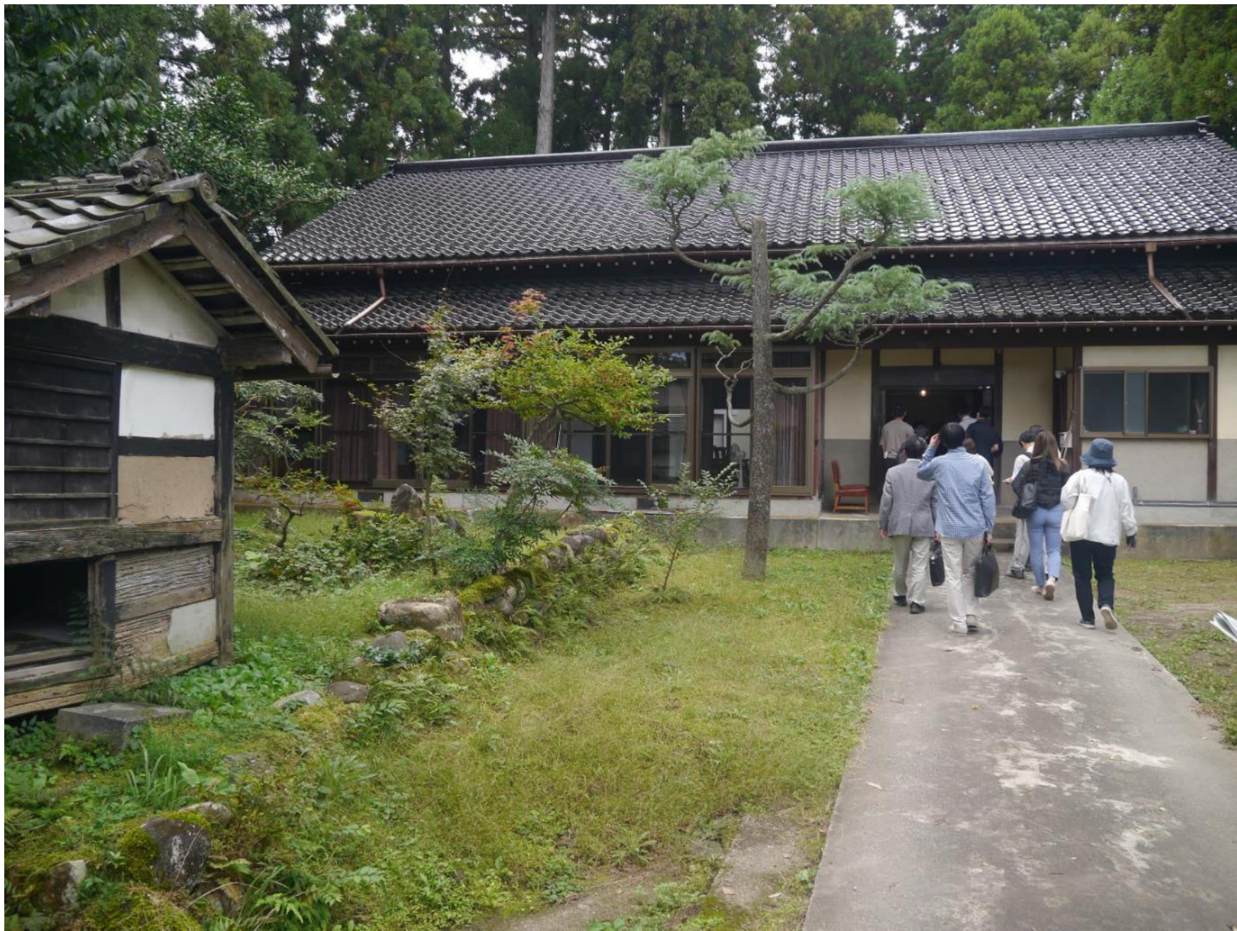
古民家を改修した「宿坊立山」。
